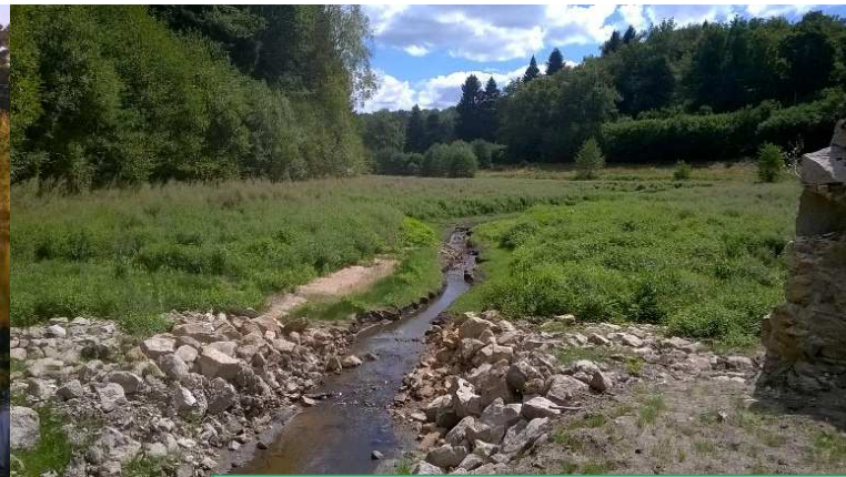
Juillet 2016 : le bassin de décantation est déconnecté, le lit du cours d'eau réaménagé et le site remis en état
