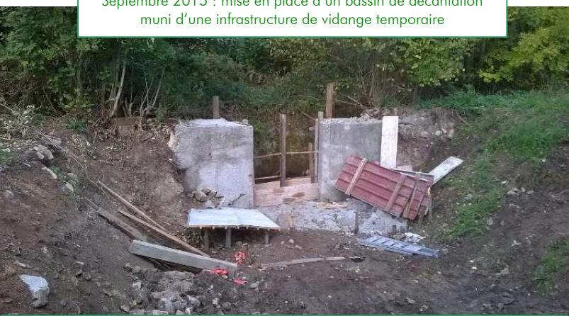
Novembre à janvier : après un premier curage du bassin de décantation, le site est laissé, le cours d'eau est dévié dans le bassin de décantation avec une déconnection possible d'une partie du débit dans le futur lit du cours d'eau en cas de crue
