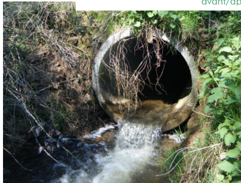
Buse ennoyée sur le ruisseau de la Fontaine au Loup avant/après travaux
