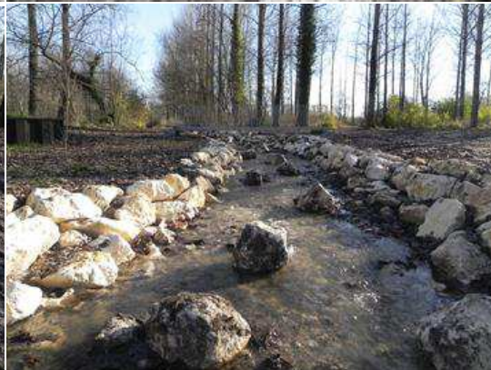
Photo après travaux De l'amont vers l'aval, contournement fonctionnel (en eau).
