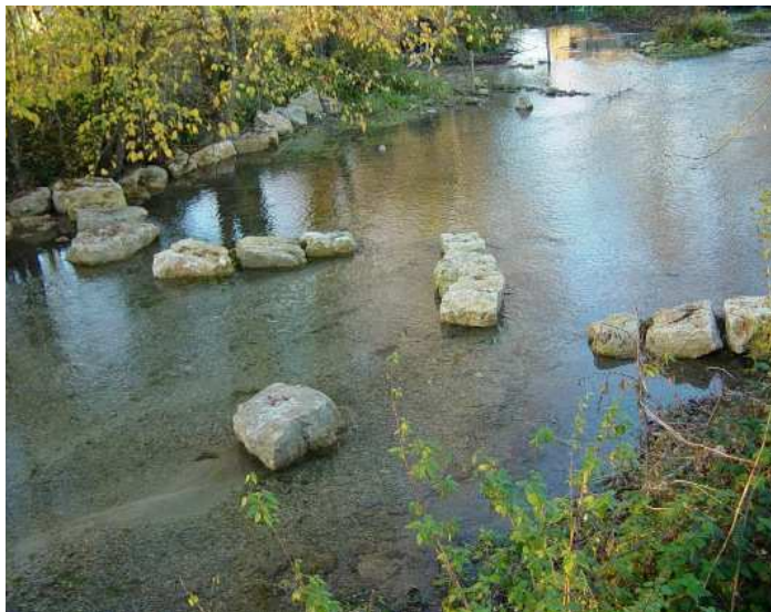
Photo après travaux
