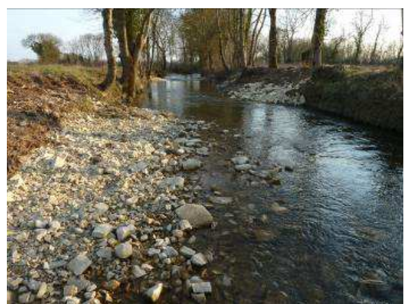
Photo après travaux
