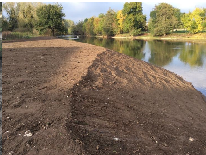
Apport 300m 3 terre végétale
