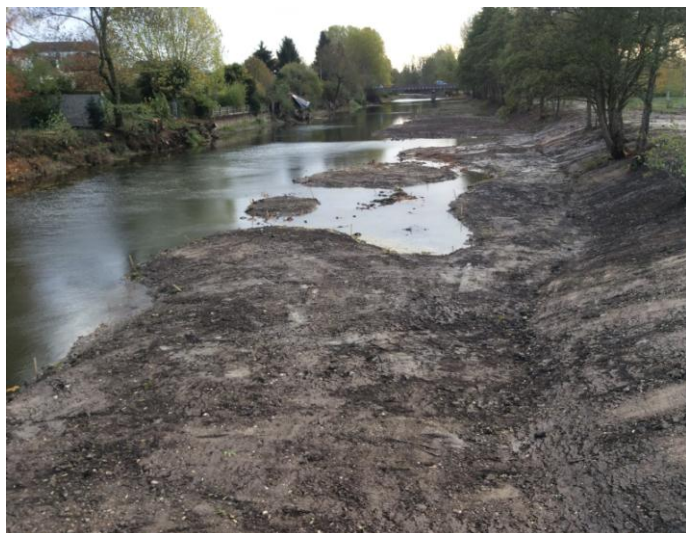
Vue des banquettes et des annexes
