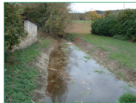
La Plate , avant travaux (photo : SIAG)
