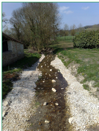
La Plate , après travaux (photo : SIAG)
